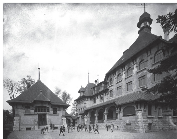
9 Ecole primaire de Sécheron et salle de gymnastique attenante (à gauche), 1914 (BGE-CIG, VG 4713).
