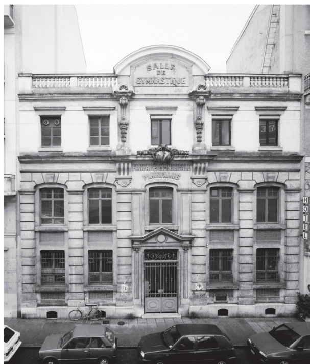
10 Salle de gymnastique de la rue des Vieux-Grenadiers, construite en 1902-1903 (Photo Gérard Pétremand, Documentation photographique Ville de Genève).
