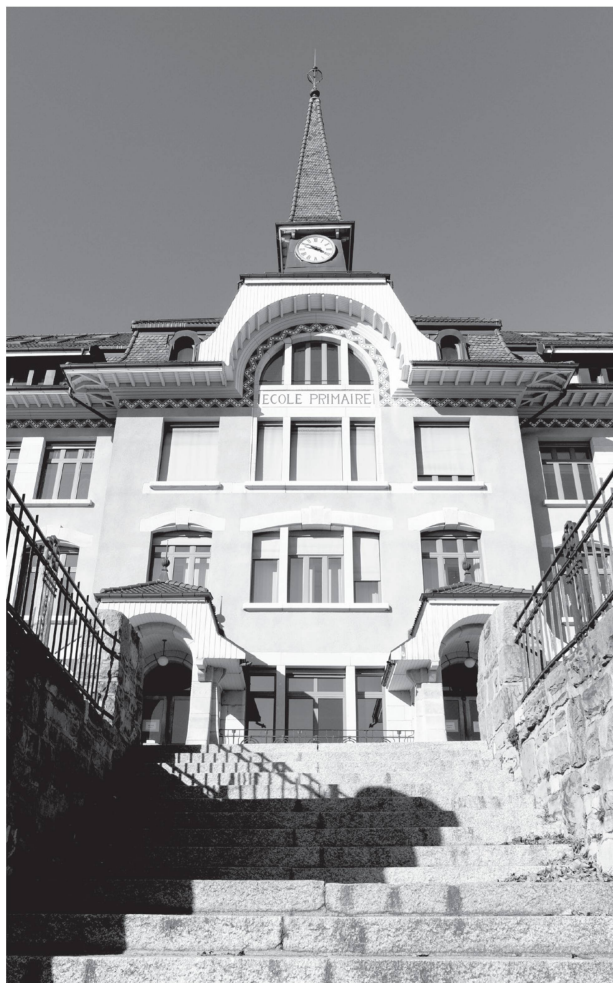
6 Collège de Prélaz à Lausanne, arch. Eugène Bron, 1908 (© Laurent Dubois).
