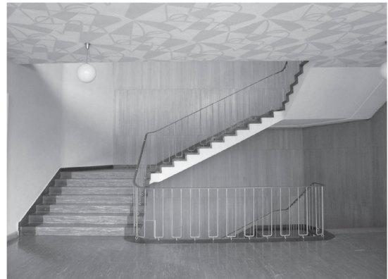
3 Construit sur les plans de l'architecte Marc Piccard, le groupe scolaire du Belvédère inauguré en 1956 a conservé l'essentiel de sa substance historique, en particulier dans les espaces communs (Photo M. Jaquet).
