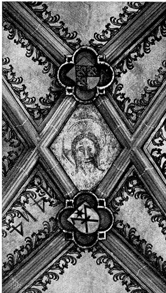
Abb. 3. Mittelpartie des Gewölbes vor der Lombachkapelle.
