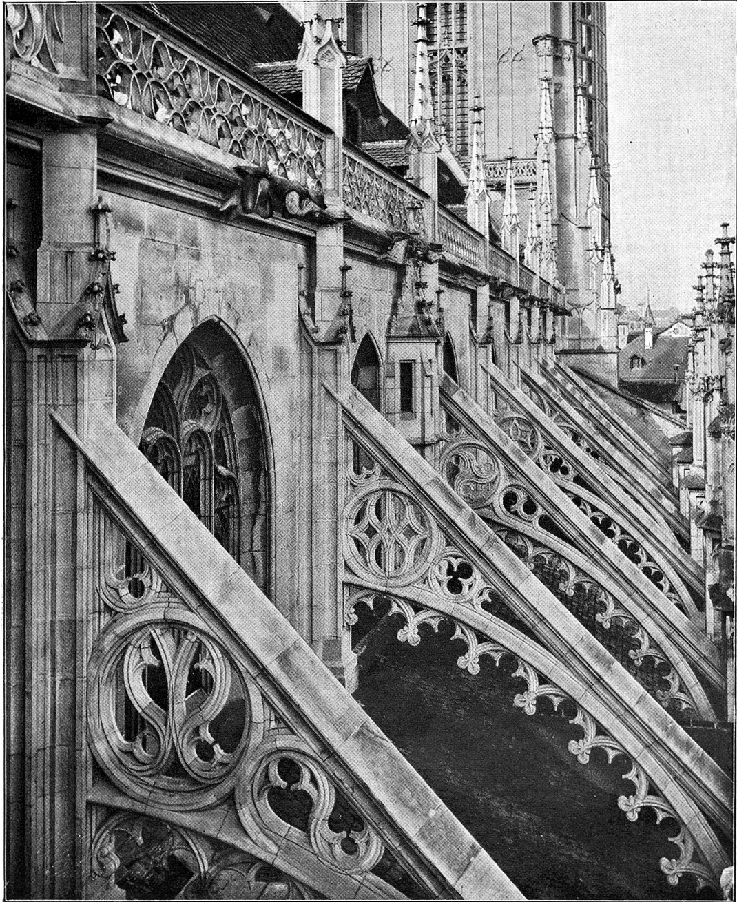
Strebebogen an der Nordseite des Münsters
