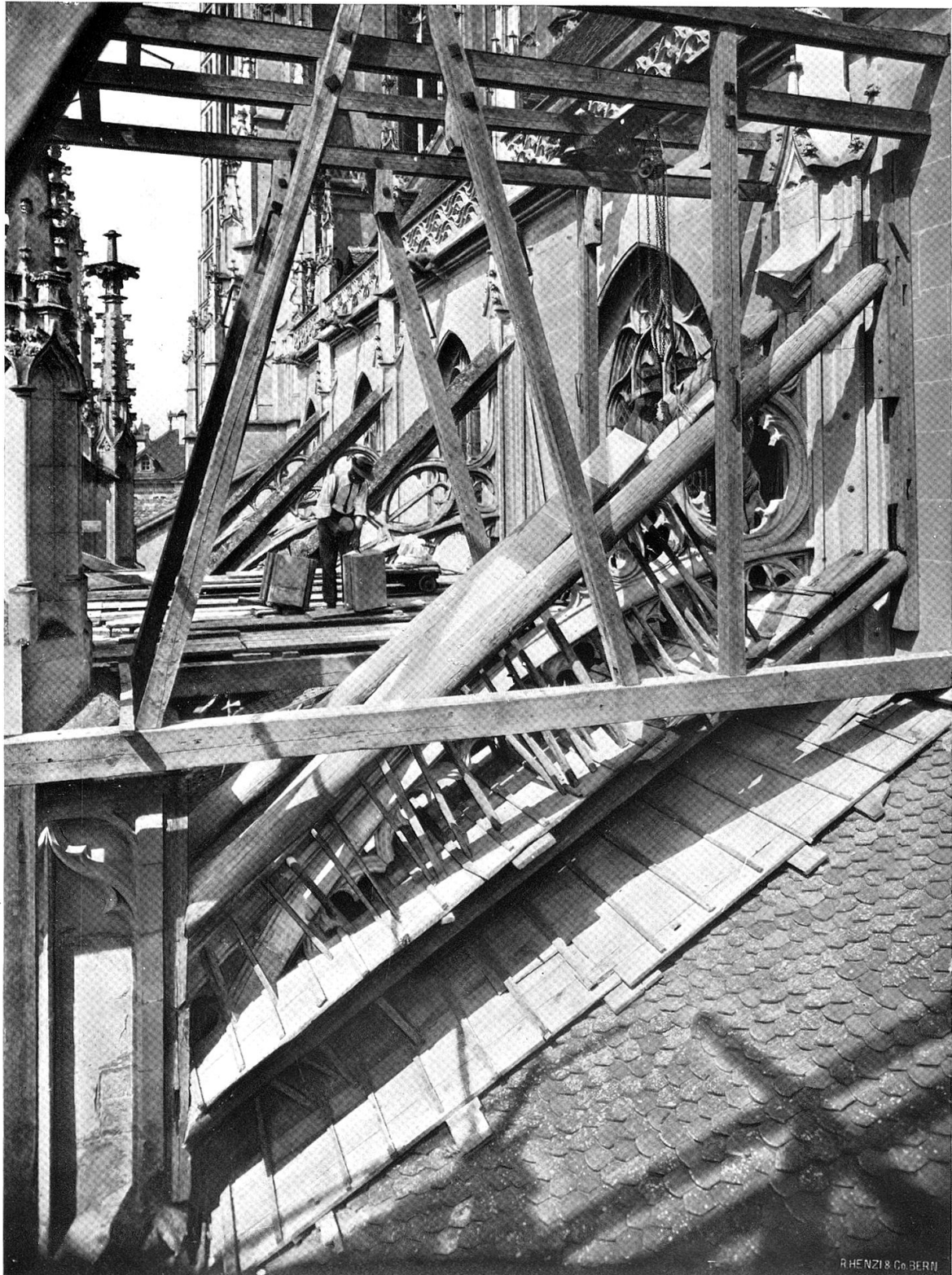
Neuer Strebebogen während des Versetzens
