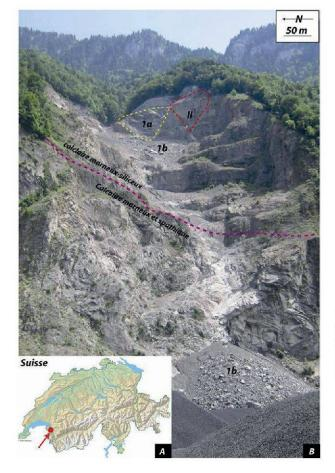
Figure 20.1.—A) Localisation de la zone d'étude. B) Vue de la partie centrale de la carrière avec la zone de l'éboulement de décembre 2008 (1a) les débris de l'éboulement (1b) et la zone potentiellement instable (II).
