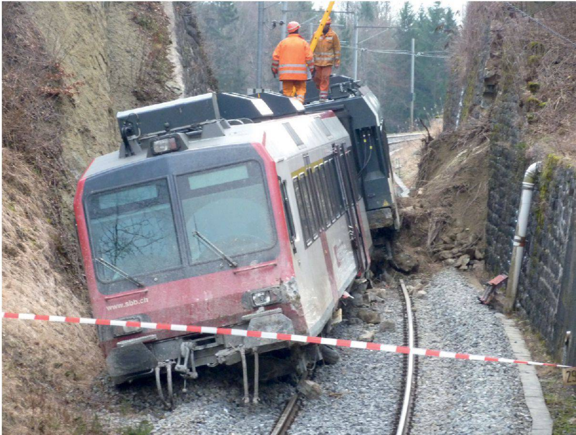
Figure 4.–Train qui a déraillé en février 2013, avec le mur qui a cédé et le dépôt des matériaux.
