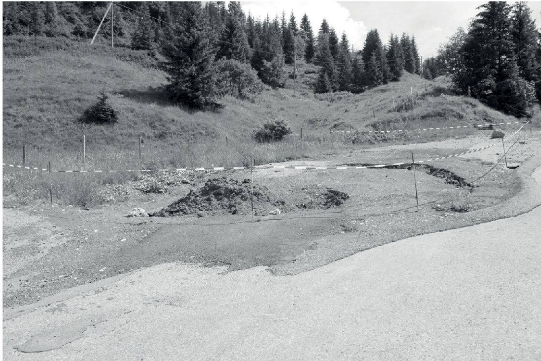
Figure 6.–Doline se développant le long de la route du col du Pillon (juin, 2009).
