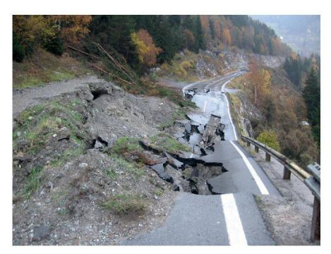
Figure 3.-Affaissement de la route de l'Arlberg proche de Strengen (Tyrol).
