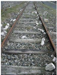
Figure 2.—Pierres sur la voie (Nantua). L'échelle est donnée par l'écartement des rails (1,435 m); photo BG / Emmanuel Rigaud.
