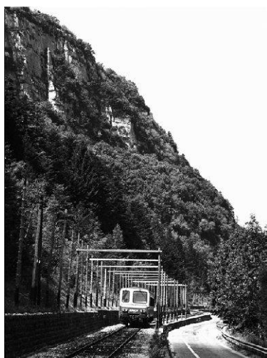
Figure 6.—Filets de détection (Nantua); photo Pascal Bejui.
