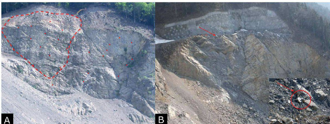
Figure 7.—A) Vue de la zone supérieure de la carrière en 2005-2006. Deux dièdres de volume similaire sont identifiables. A gauche, entouré en noir, le dièdre qui s'éboulera en décembre 2008 et à sa droite un autre dièdre de taille et caractéristiques similaires. B) Vue de la zone supérieure de la carrière après l'éboulement du dièdre de 20'000 m 3 en décembre 2008.
