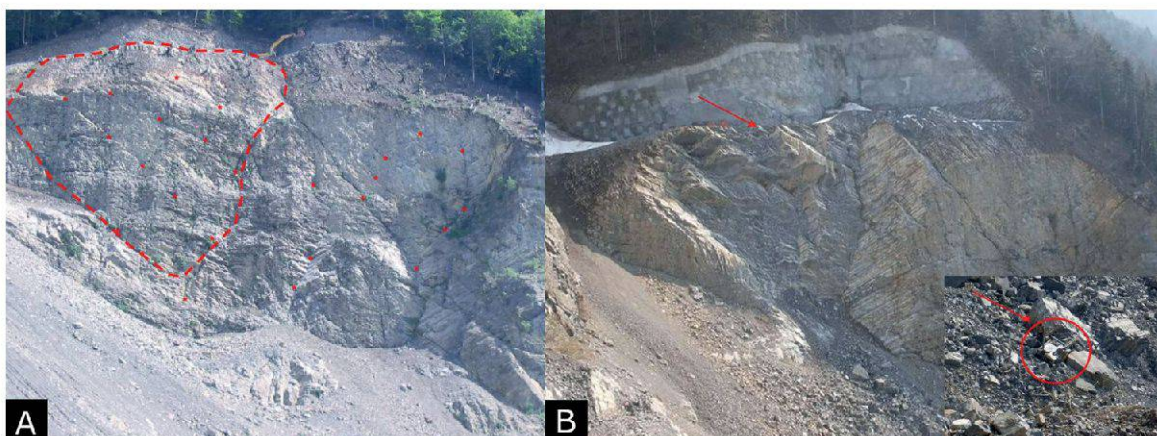
Figure 7.—A) Vue de la zone supérieure de la carrière en 2005-2006. Deux dièdres de volume similaire sont identifiables. A gauche, entouré en noir, le dièdre qui s'effondrera en décembre 2008 et à sa droite un autre dièdre de taille et caractéristiques similaires. B) Vue de la zone supérieure de la carrière après l'éboulement du dièdre de 20'000 m 3 en décembre 2008.
