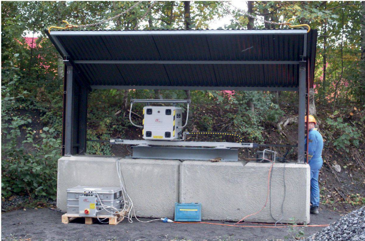
Figure 4.–Système d'interférométrie radar GB-InSAR installé aux Carrières d'Arvel depuis octobre 2009.
