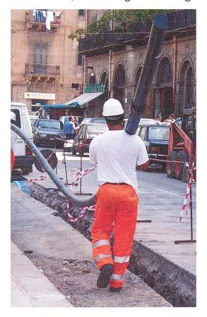
Abb. 2: Grabenverlegung einer Polyethylen-Wasserleitung in Palermo
