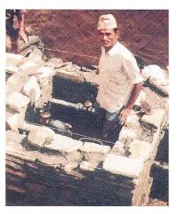
Abb. 5: Erstellen einer Schieberkammer
