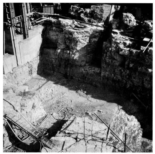
Foto 3: Bereich Widerlager links, weit unter Rheinspiegel: Plattiger Malmkalk mit ausgeprägter Klüftung (27. 8. 1964)
