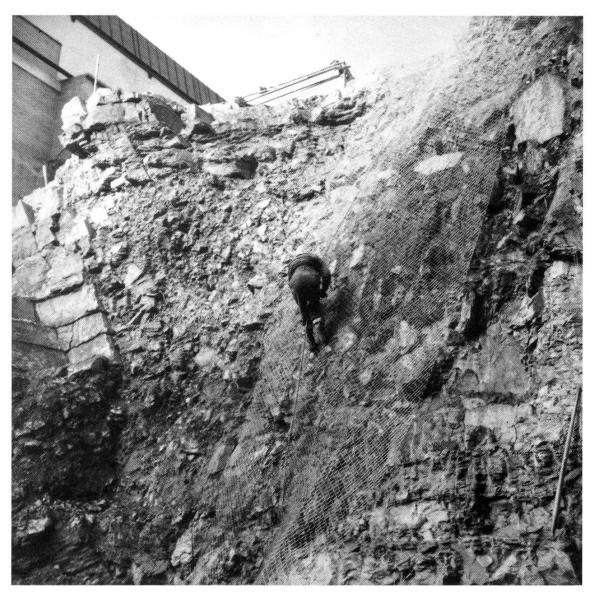
Foto 4: Doline, mit Kalkschutt und Bohnerzton aufgefüllt, trocken. Fallschacht, nahe rechtem Ufer, unter Rheinspiegel (16. 12. 1961)
