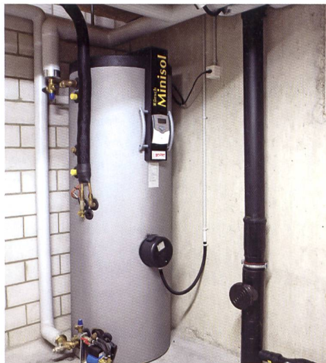
Un boiler per l'acqua calda ad energia solare.
