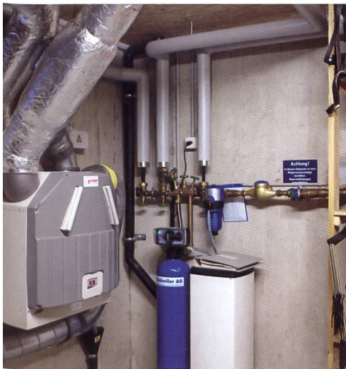
Lo scambiatore di calore installato in cantina costituisce il motore del riscaldamento della casa. Il calore dell'aria in uscita permette di temperare quella in entrata.
