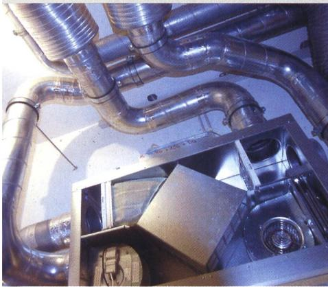
La base della ventilazione controllata si trova in cantina nel locale riscaldamento e aspira aria fresca dall'esterno.
