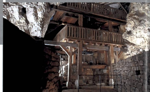
Mulini sotterranei Col-des-Roches, Le Locle/NE
