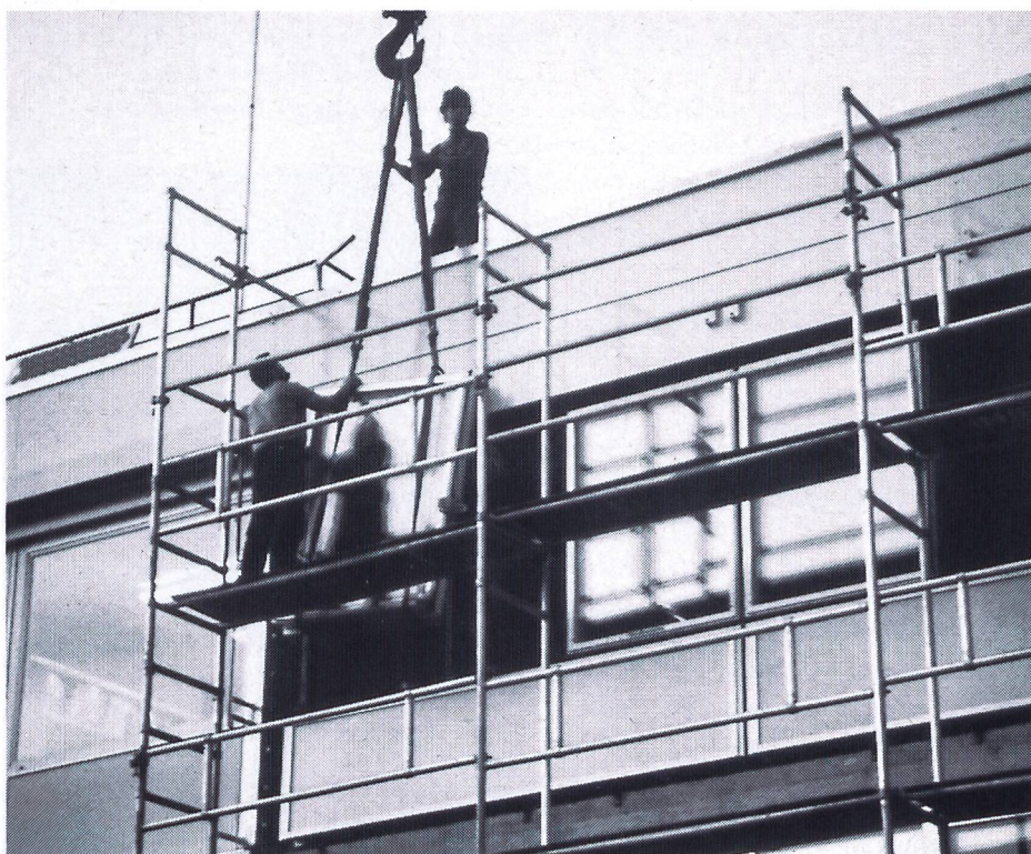
Sostituzione di un pannello sull'edificio del LESO: ogni parete comporta tre sistemi di energia solare diversi. Una dozzina di pareti sono già state sperimentate al LESO.
