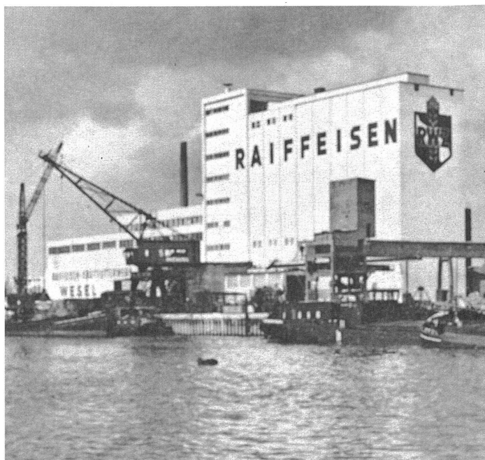
Silo per foraggi a Wesel della Centrale merci Raiffeisen della Regione renana.
