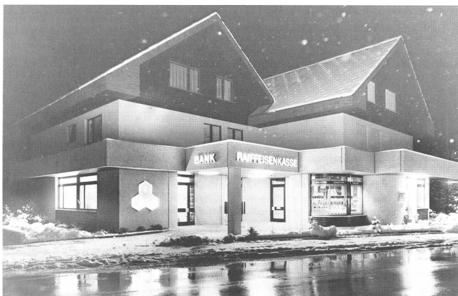
La Cassa Raiffeisen di Thierachern-Uebeschi, una delle 18 del circolo di Thun, con 20 milioni di bilancio, ha realizzato la propria sede seguendo la via della proprietà per piani, in uno stabile con diversi negozi.
