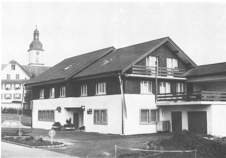
Anche a Dietwil, la Cassa Raiffeisen locale, attiva da 36 anni in questo villaggio di 720 abitanti, ha realizzato la propria sede con la Posta. A sinistra, la sede della Cassa Raiffeisen con, al pianterreno, uffici e atrio sportelli, camera corazzata con cassette di sicurezza per la clientela; al primo piano e secondo piano l'appartamento del gerente. A destra la Posta con l'appartamento del buralista. La Cassa Raiffeisen di Dietwil conta 170 soci, 10 milioni di bilancio e 35 milioni di movimento.
