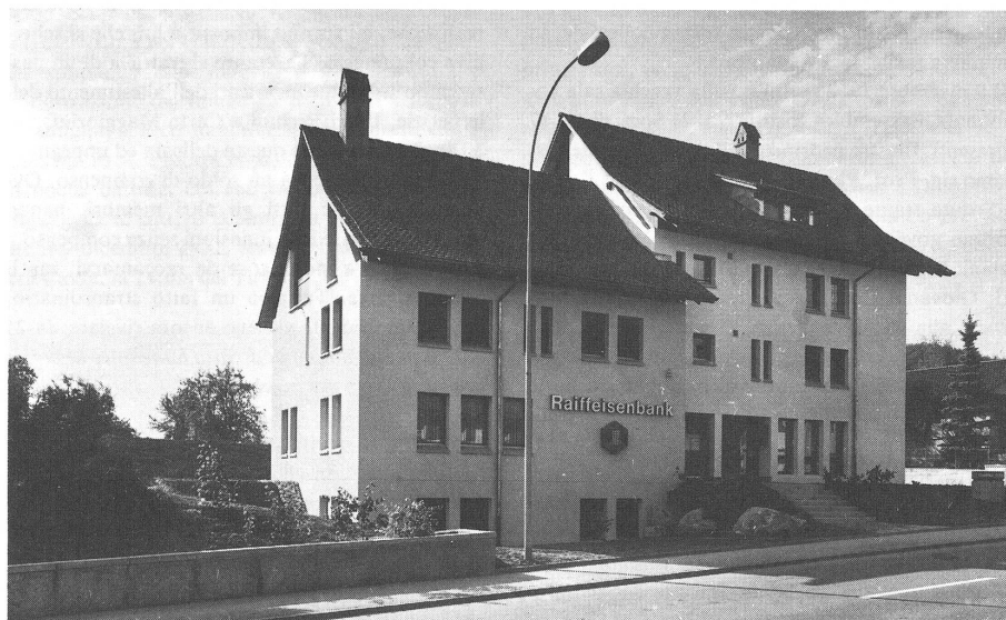
La Banca Raiffeisen di Beromünster, attiva da 76 anni, ha realizzato una sede confacente alla sua intensa attività (550 soci, 30 milioni di bilancio, 130 milioni di movimento) in un comune di 6000 abitanti.
