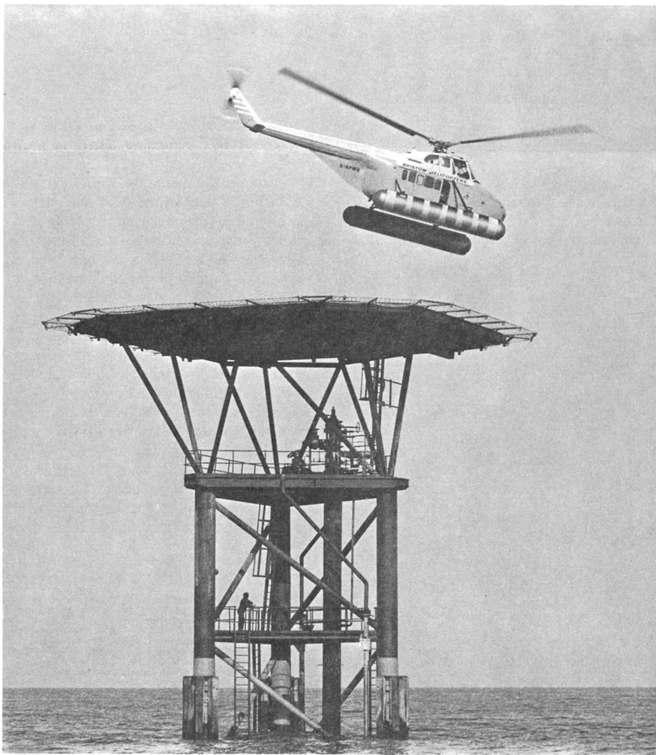
Torre di un giacimento di petrolio scoperto dalla Abu Dhabi Marine Areas Ltd., consociata della British Petroleum Company e della Compagnie Française des Pétroles. Ben riconoscibile, sotto la piattaforma per l'elicottero, l'«albero di Natale», e cioè il sistema di valvole che serve per regolare il flusso del greggio. La «testa» del pozzo può pure essere sistemata sott'acqua, con collegamento mediante tubazioni che consentono il trasferimento diretto del greggio alle petroliere.
