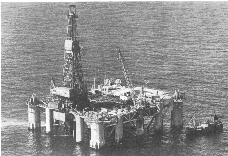
Lo «STAFLO», un'unità semisommergibile per perforazioni, progettata per affrontare le più difficili condizioni meteorologiche e mantenere condizioni ottime di stabilità. E' costituita da uno scafo semigalleggiante — sommerso a profondità variabile tra i 15 e i 25 m, collegato alla piattaforma fuori acqua mediante una struttura che non offre resistenza al passaggio delle onde — e da grossi piloni stabilizzatori.
