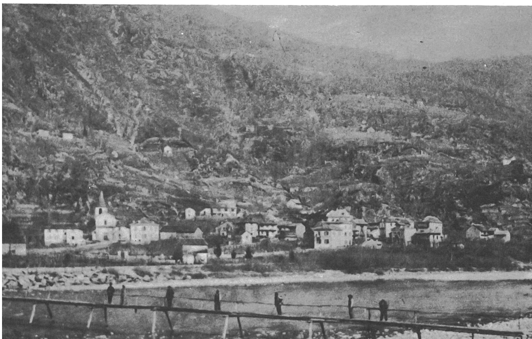
L'antico ponte (1890-1900 circa) che collegava Carasso con Bellinzona. In caso di piena, per quanto in tempo e per quanto possibile, lo si smontava, prima che le acque del Ticino lo asportassero.
