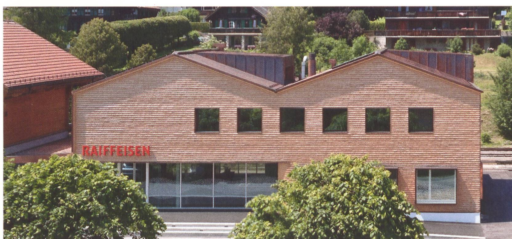
Plusieurs bâtiments Raiffeisen respectent les standards Minergie en Suisse romande, comme à Vernayaz (Minergie-P, en haut à droite), Chateau-d'Oex (Minergie-P, en bas) et bientôt Belfaux (Minergie-Eco, en haut à gauche) – ouverture en juin 2013.
