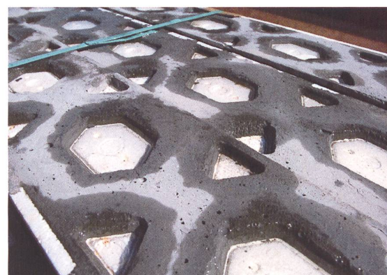
Des solutions spéciales ont dû être trouvées pour les matériaux, comme par exemple les briques d'isolation ou les tiges en fibre de verre pour l'armature des parois de béton (en haut).
