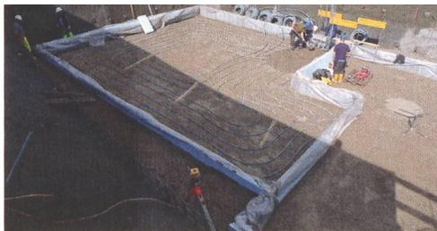
Deux éléments distinctifs de cette construction d'avant-garde: l'accumulateur de chaleur sous la dalle du rez et les panneaux solaires sur le toit.
