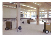
Assèchement des bâtiments
