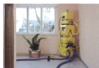
Assèchement après dégâts d'eau
