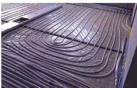
En ce qui concerne le chauffage au sol, la circulation d'eau à basse température nécessite une densité élevée de serpents.
