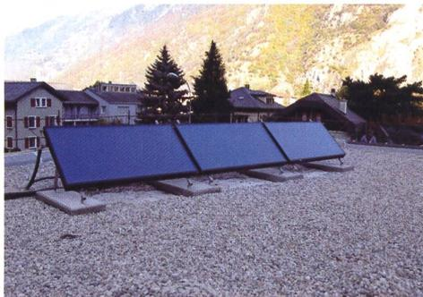
Les panneaux solaires sur le toit assurent le préchauffage de l'eau sanitaire.
