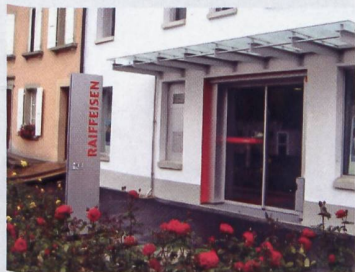
L'entrée principale du bâtiment qui a été transformé de fond en comble pour les besoins de la banque.
