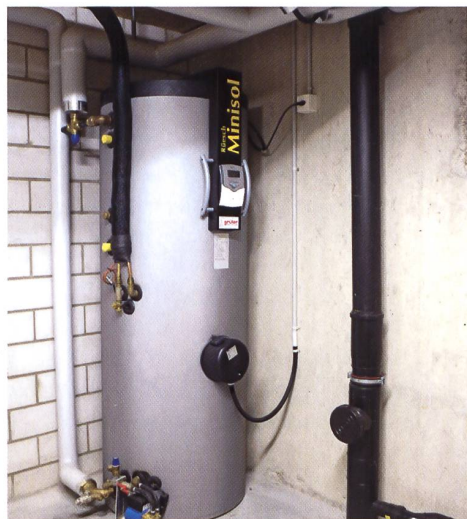
Boiler pour l'eau chauffée à l'énergie solaire.
