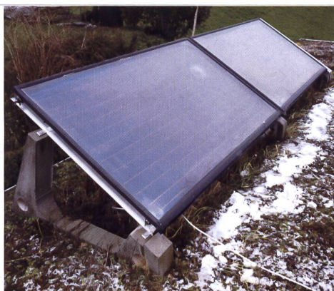
Les panneaux solaires sur le toit répondent aux deux tiers des besoins de la famille en eau chaude. L'énergie renouvelable fait partie du programme Minergie-P.
