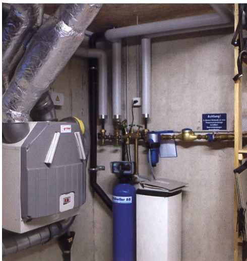
L'installation d'échangeur de chaleur à la cave constitue le moteur de la ventilation dans la maison. La chaleur de l'air sortant permet de tempérer l'air entrant.
