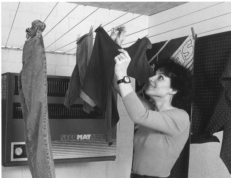
nette amélioration de la situation. Le local de séchage a été équipé d'un sèche-linge SECOMAT. Grâce à un échange d'air important et une forte ventilation, ces appareils sont non seulement d'excellents sèche-linge, mais ils assèchent également les murs en profondeur et les maintiennent sec.
