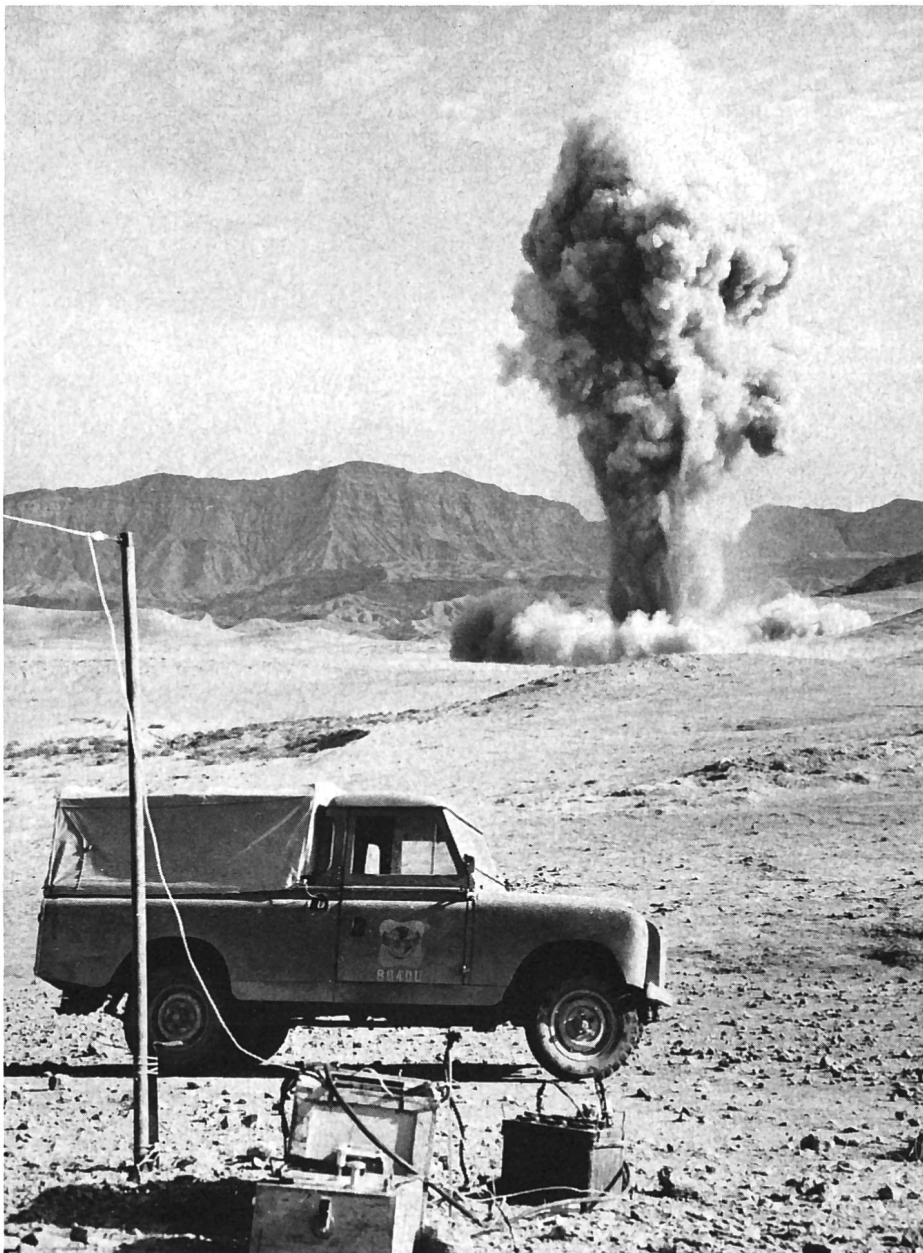
Iran — Recherche : Tir sismique effectué lors d'une campagne de géophysique.
