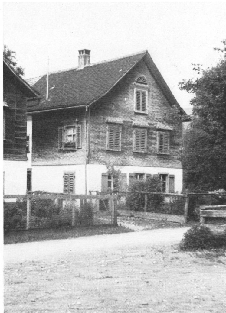
Abb. 72 * Kleines Stickerhaus im Nordteil von Weite; Holzbau
