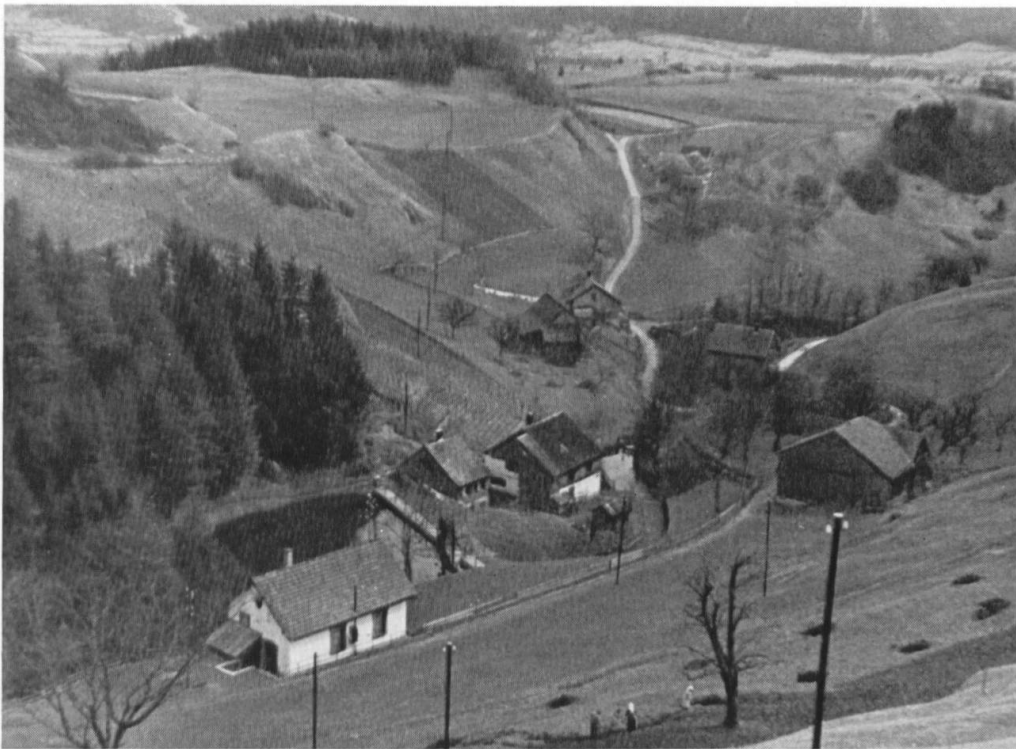
Abb. 34* Tobel mit Elektrizitätswerk Oberschan und Stauwehr der Weberei Azmoos
