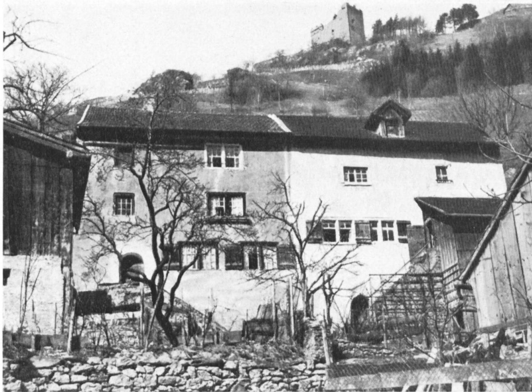
Abb. 64 * Steinbauten in Murriss
