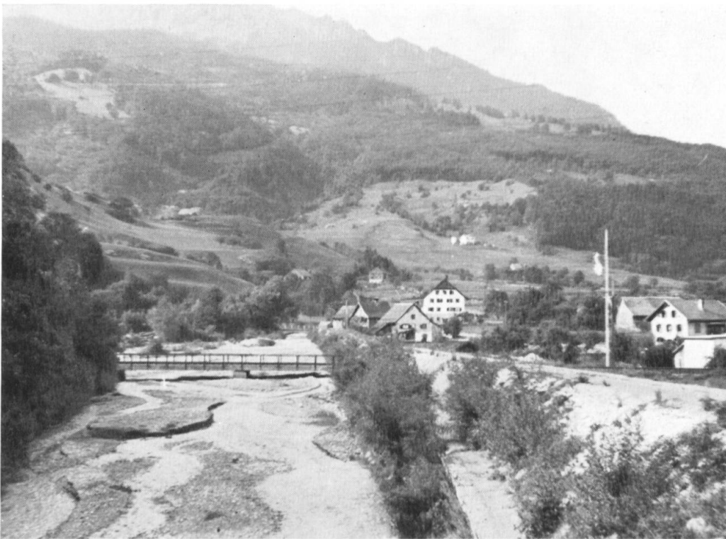
Abb. 24 * Unterlauf des Trüebachs, starke Schuttablagerung im breiten Bett; Bildmitte: Eisenbahnbrücke
