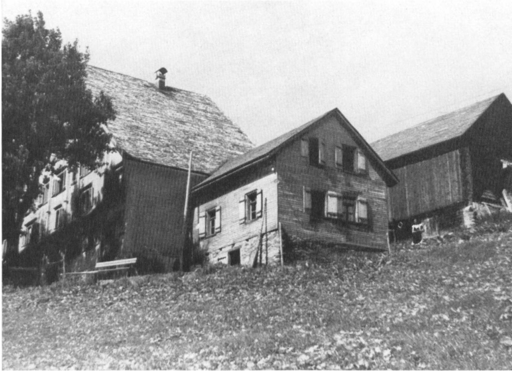
Abb. 81* Kurhaus Palfris (abgebrannt), alter Holzbau
