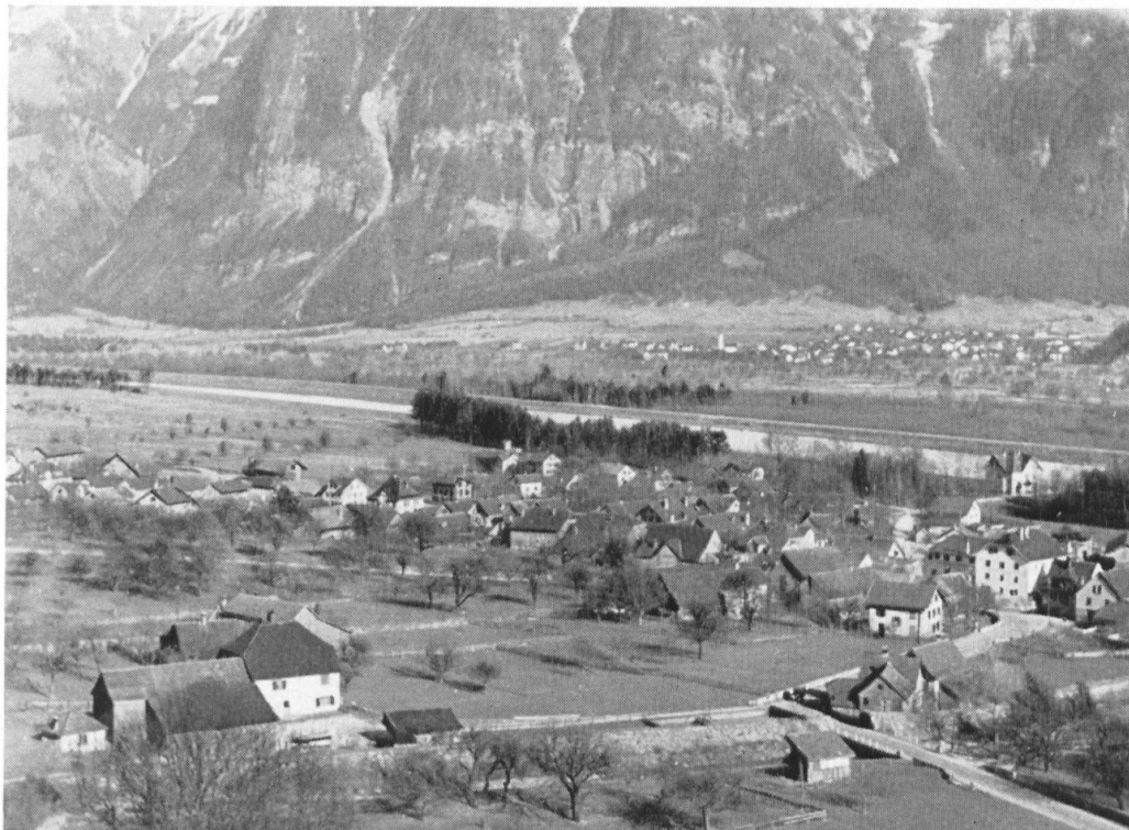
Abb. 48 * Trübbach von Westen. Blick gegen Rhein und Balzers (Liechtenstein)
