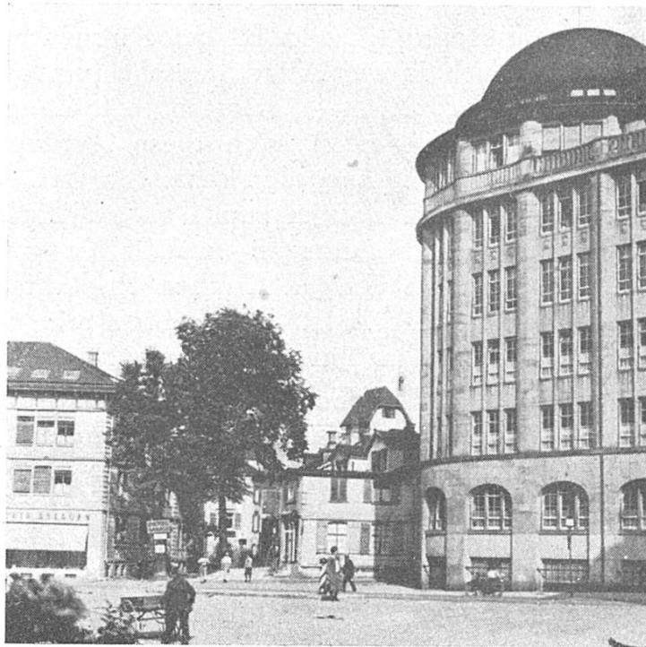
59. Partie an der Teufenerstrasse mit unausgeglichenen Siedlungsteilen. Nest niederer alter Bauten, links davon ein einfaches Geschäftshaus, rechts die Ecke eines grossen Stickereiexporthauses.
