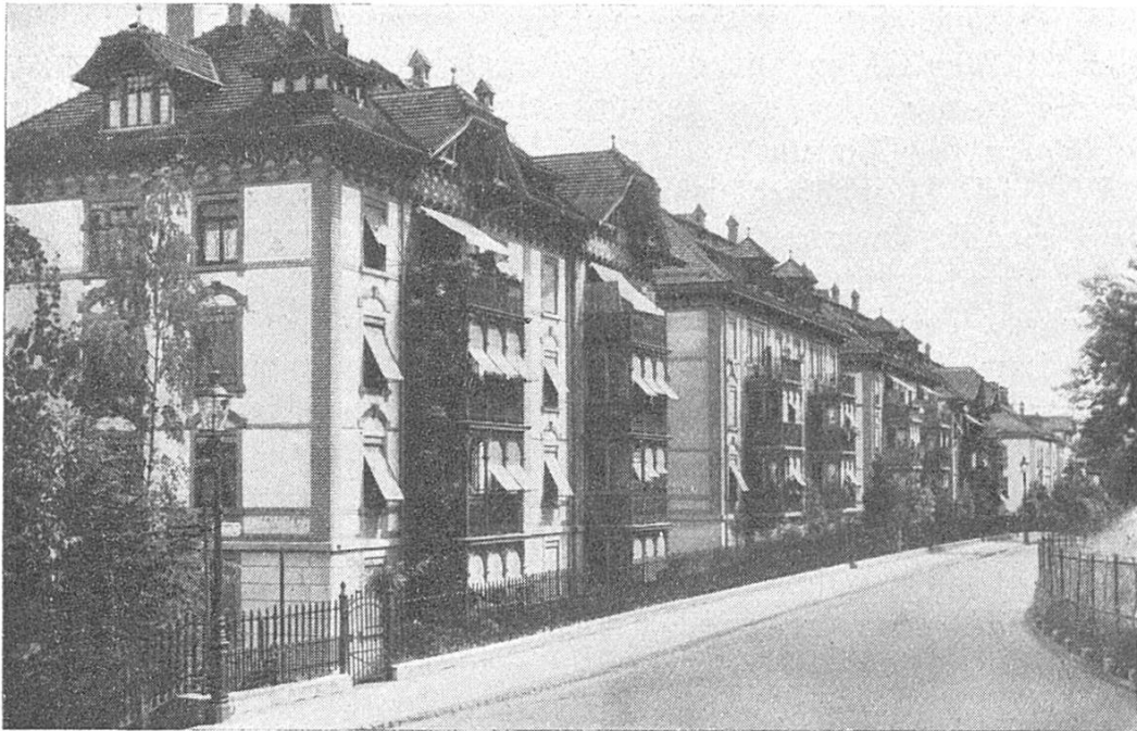
61. Wildeggstrasse. Wohnhäuserreihe in erhöhter Lage nahe der Altstadt.
