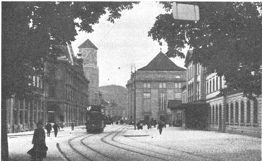
50. Das Bahnhofgebiet von Osten. — Rechts vorn das alte Bahnhofgebäude, nachher der neue Hauptbahnhof. — Links vorn die „Walhalla“, darauf das Rathaus (ehemals Post), schliesslich die neue Post (mit Turm).
