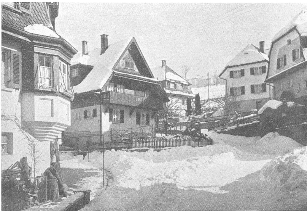
60. Blick in die Eisenbahnerkolonie Schorenhalde.
