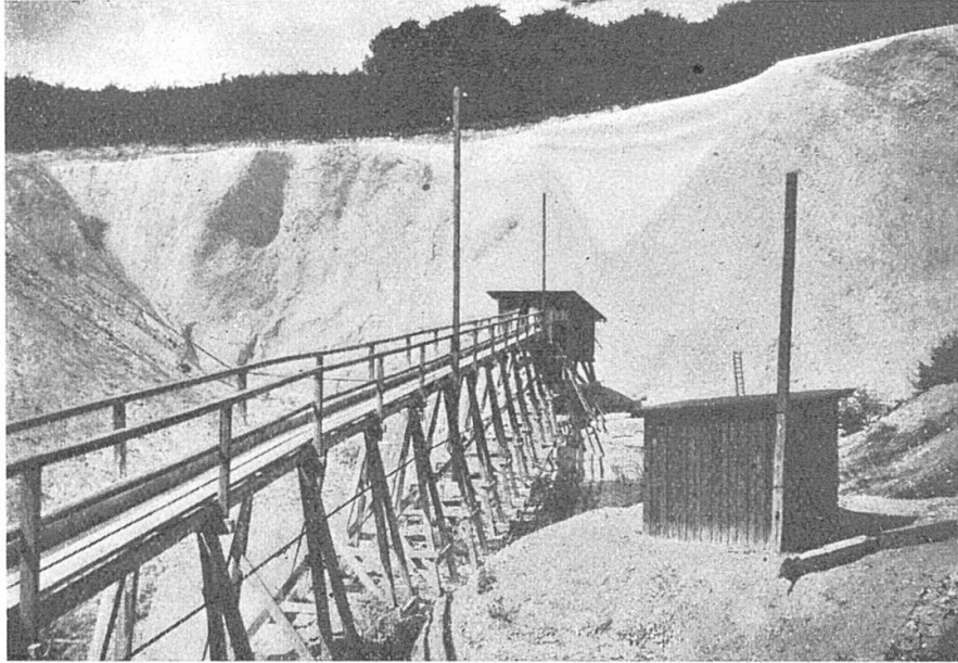
Ueberleitungseinrichtung in der Gemeindegrube Sassnitz.
