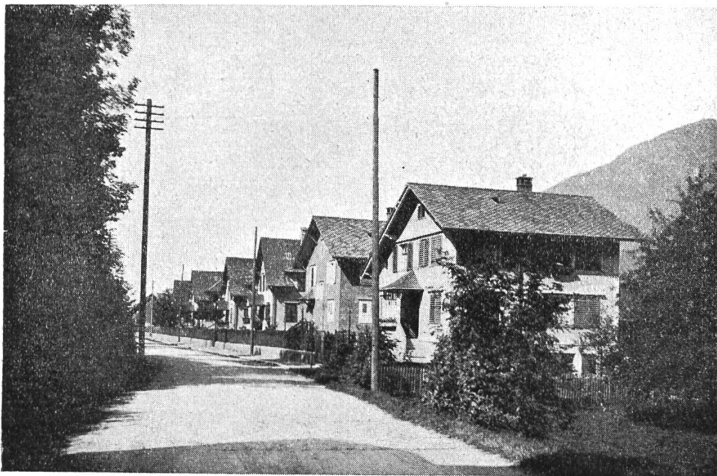
Photo Nr. 24. Eternithauskolonie bei der Vorburg zwischen Ober- und Niederurnen. — Von der Oberurnerseite aus aufgenommen.
