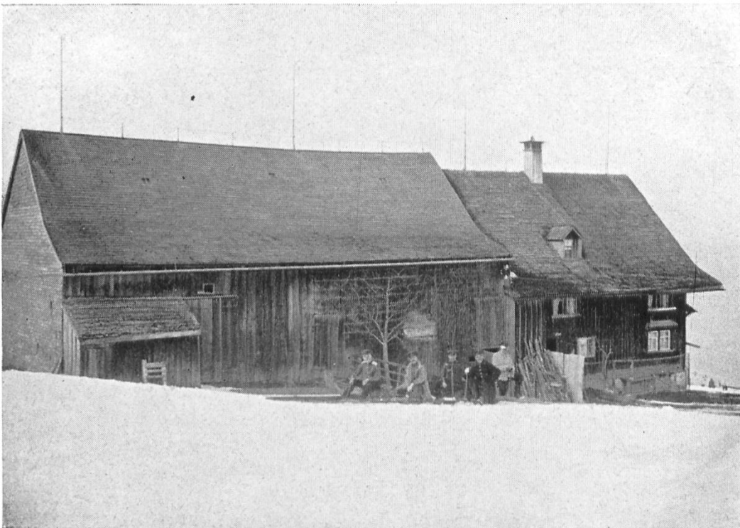
Bauernhaus mit Wohngebäude und angebautem Gaden mit gleicher Firstrichtung. Derselbe überragt das Wohnhaus um ca. 1 m. Unter der Wohnstube befindet sich der Webkeller.
