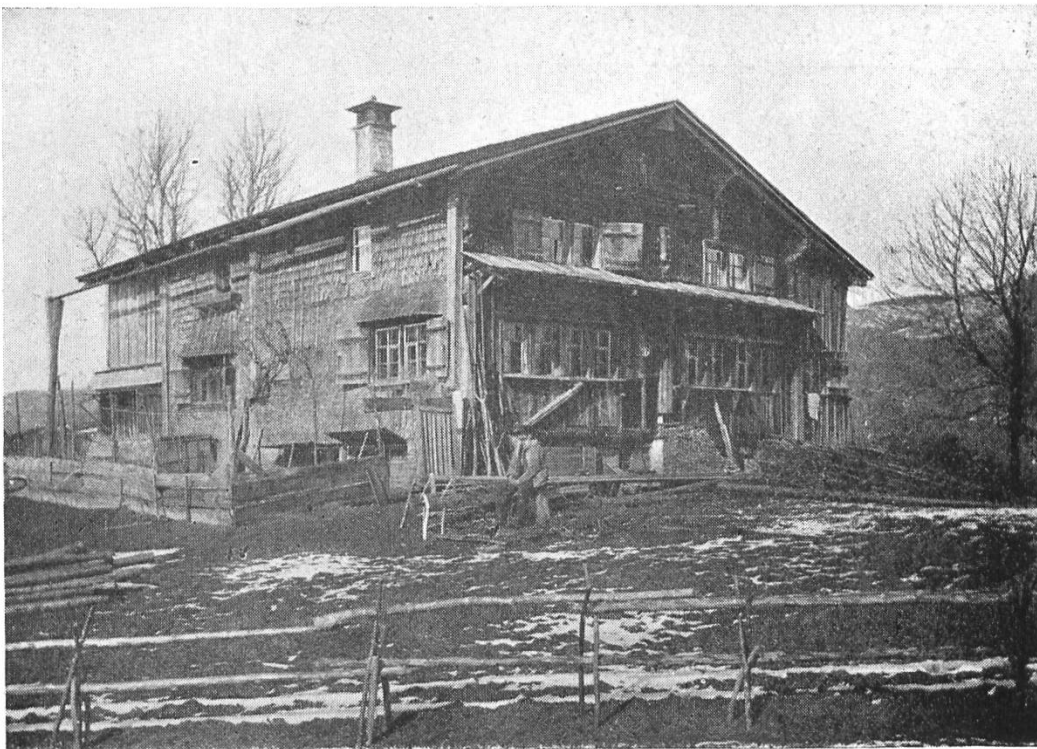
Tätschhüsli in der Weid, mit Giebelfront. Giebelseite unten verschalt, oben einen Blockbau, Traufseite verschindelt. Primitives Klebdach. „Chaßestege“. Webkeller. Als Wetterschutz hinten der Schopf angebaut, ebenfalls auf einer Traufseite.
