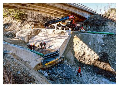
Abb. 2: Links: Der Illgraben mit dem Meretschihorn im Hintergrund (Bild: Christoph Schwörer). Rechts: Einbau der Murgangwaage im Illgraben (Bild: Brian McArdell, WSL).
