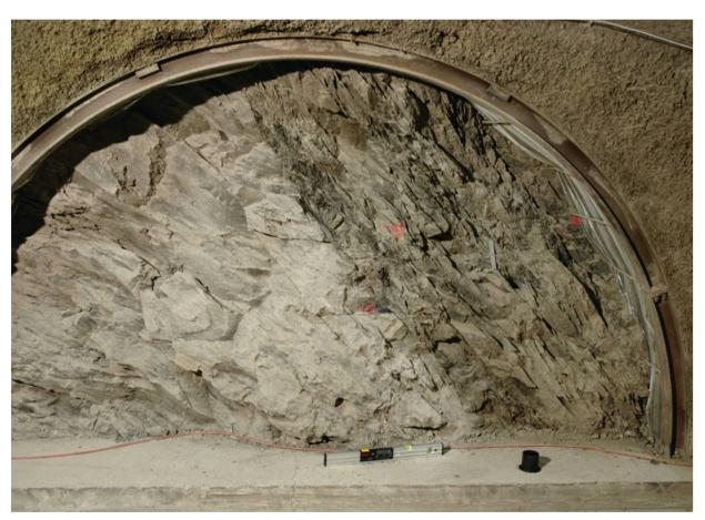
Abb. 3: Aufschluss des Opalinustons unter einem Stahlbogen im Felslabor Mont Terri (JU). Links (heller) ist das Gestein wenig bis gar nicht deformiert, rechts (dunkler) ist eine grosse, 45° nach rechts einfallende Bruchzone erkennbar. Bildbreite ca. 3 m.
