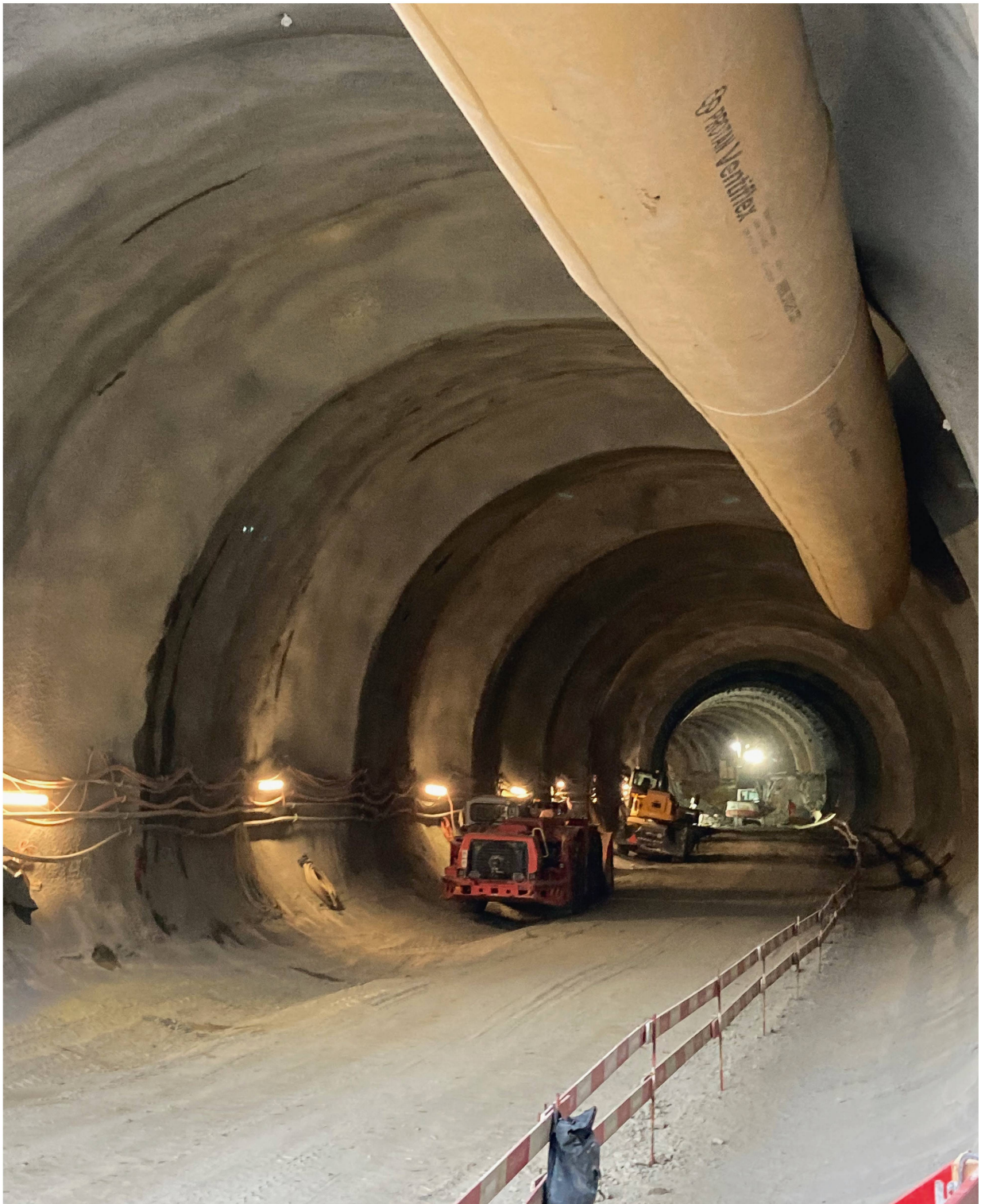
Abb. 2: Blick vom Hirschenpark Richtung Eilgut in den entstehenden RBS-Tunnel. Oben ist die halbkreisförmige Kalotte zu erkennen, die gut gesichert ist. Unten wird die Sohle in einer zweiten Bauphase nochmals 3 bis 4 m abgeteuft. Foto: Matthias Giger.
