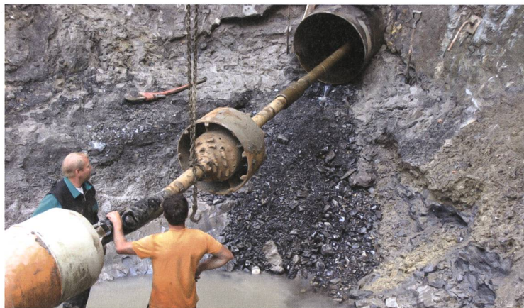
Tafel 1, Foto 3: Zielschacht Rohrvortrieb Nord, Baugrubenabschluss Süd unter Foto 1 anschliessend. Chaotisch gelagerte (? Glazialtektonik) Kiesbänke und Lehmlagen, beige- bis schwarzgrau gebändert.
