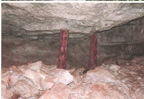
Abb. 22: Zwei Stützbalken der Kristalhöhle. Vom rechten Balken stammt Probe 43267.
