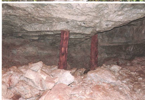
Abb. 22: Zwei Stützbalken der Kristallhöhle. Vom rechten Balken stammt Probe 43267.
