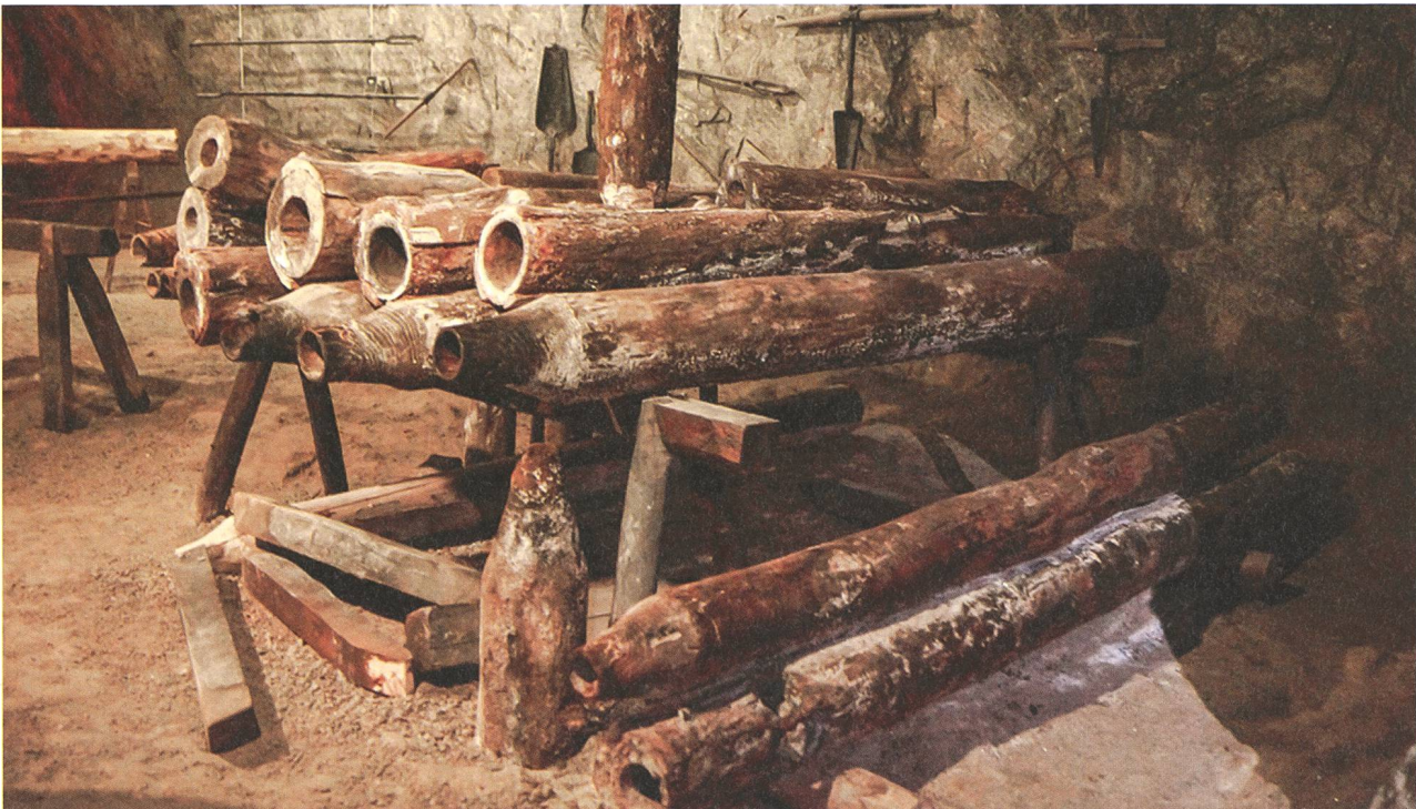
In Rohrleitungen aus ausgehöhlten Lärchenstämmen wurde die Salzsole früher über Kilometer transportiert.
