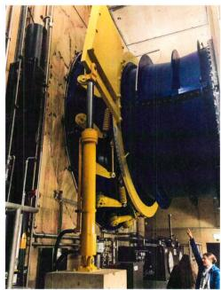
Beeindruckender Drehschieber, welcher den Wasserfluss zur Turbine regelt.
