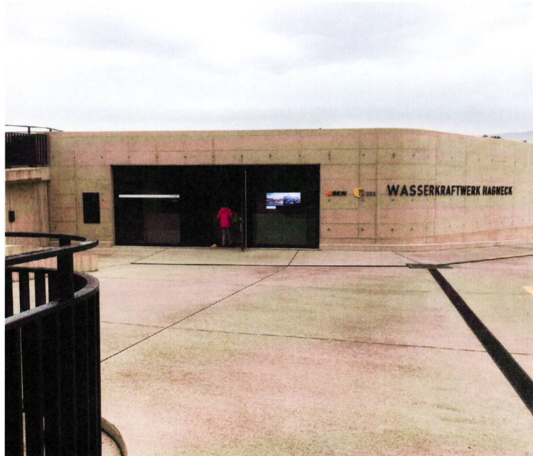
Moderner, ja schon fast futuristischer, aber in schlichter Sichtbe- tonweise gehaltener Eingangsbereich ins Kraftwerk.
