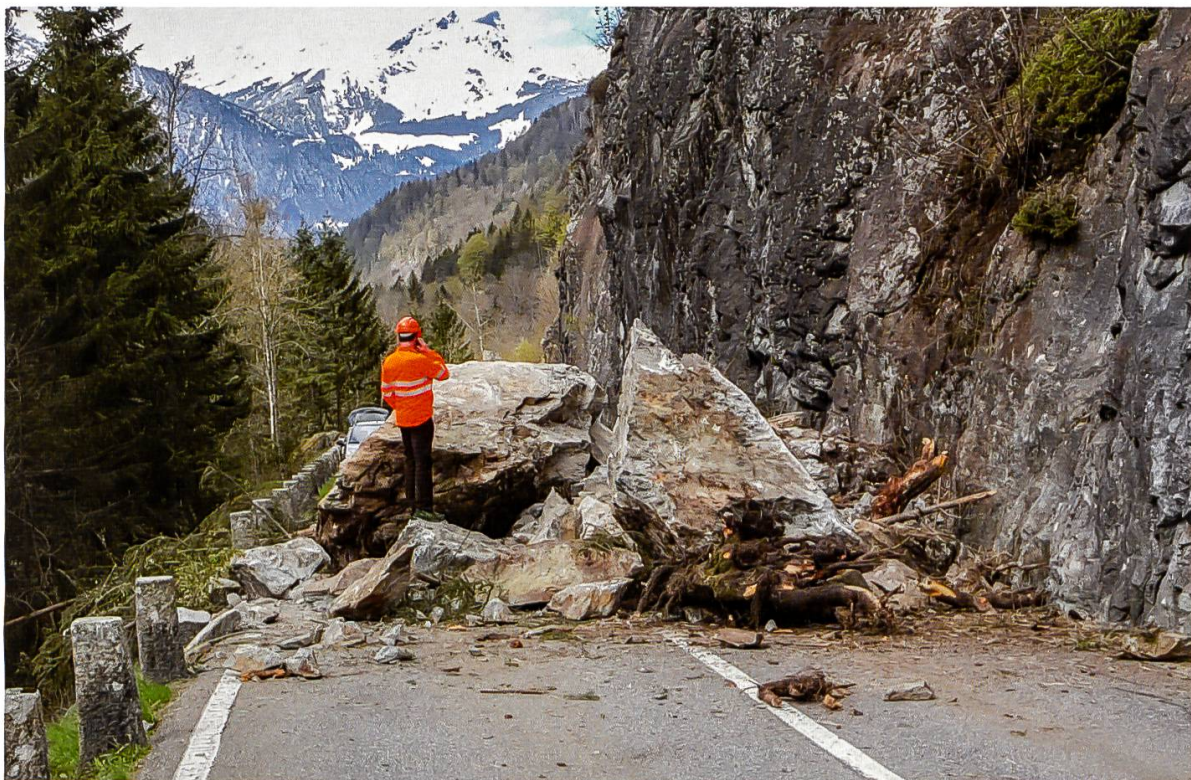
Abbildung 8: Am 28. April 2016 stürzten um 9.00 Uhr, nach Schneeschmelze und einer kalten Nacht, rund 50 m 3 Fels direkt auf die Sustenpasstrasse unterhalb von Gadmen. Der grösste Block hatte ein Gewicht von etwa 30 Tonnen.
