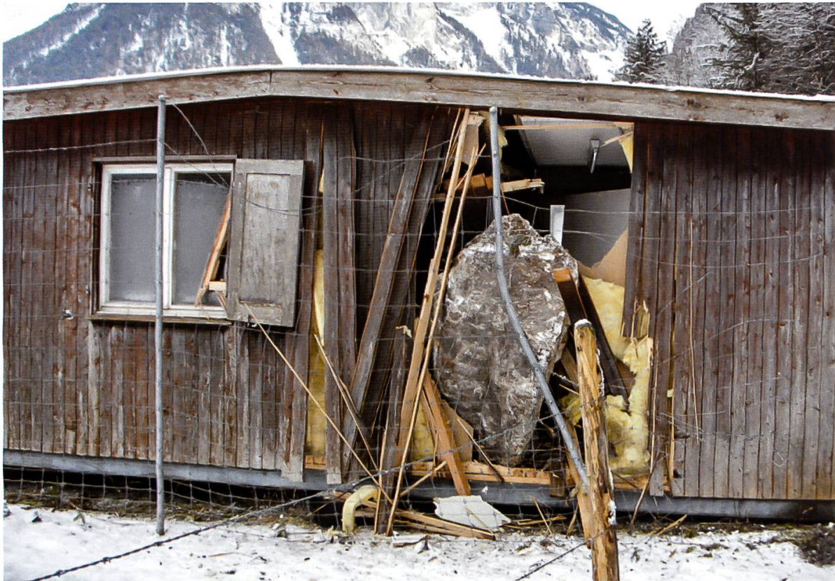
Abbildung 11: Starke Temperaturwechsel zwischen -10^{\circ}\text{C} und +5^{\circ}\text{C} lösten im Januar 2009 in einer Felswand bei Innertkirchen einen Abbruch von rund 300\text{m}^3 aus, wobei ein Block eine Baracke stark beschädigte.
