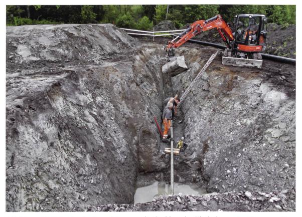
Abbildung 14: Zielgrube der Ersatzleitung nach Abschluss der Pilotbohrung. Im Hintergrund befindet sich das «Lörmoos». (Foto: Thomas Leu)
