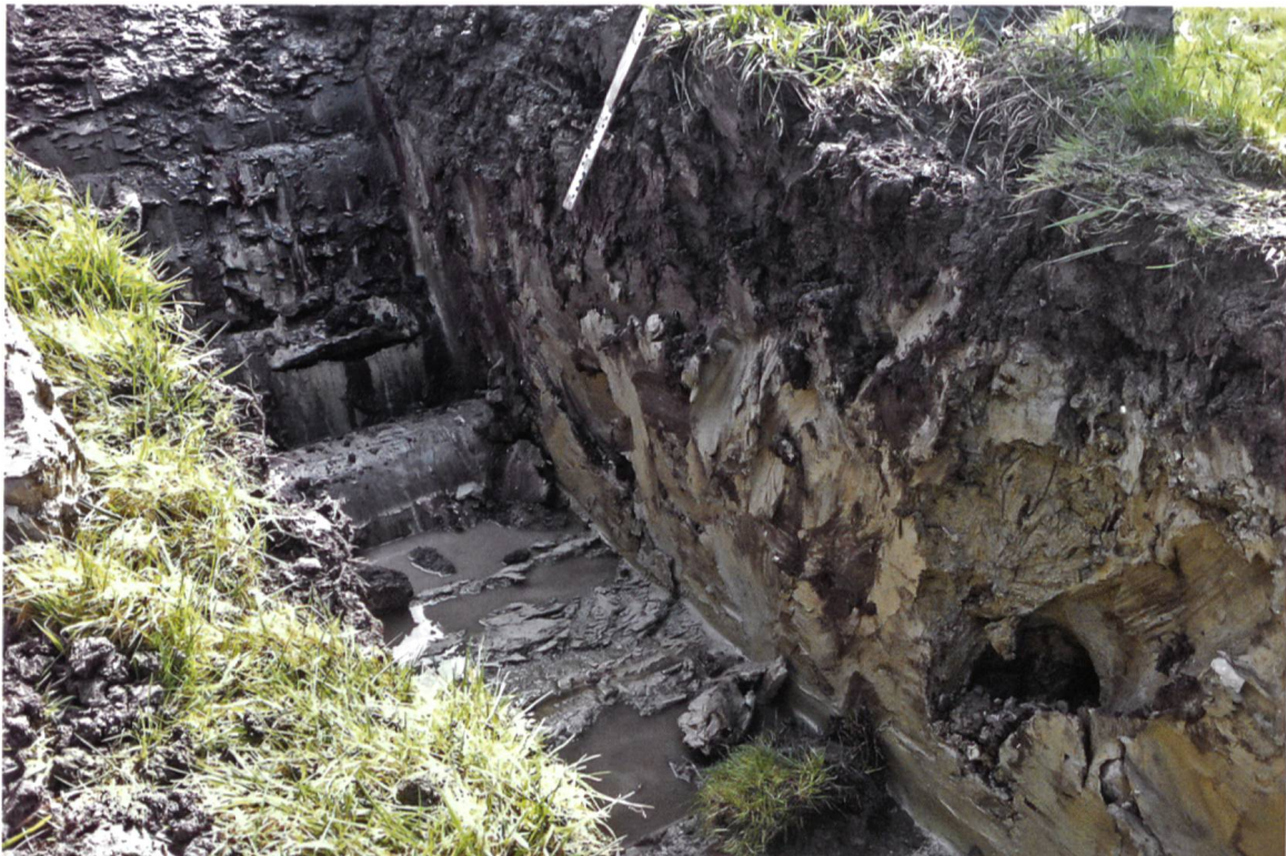
Figure 19: Sondage à la pelle mécanique. (Photo: Olivier Bessire)
