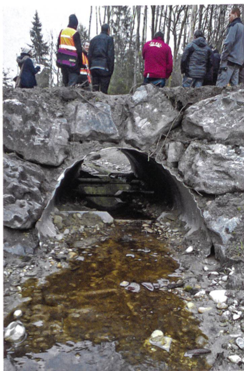
Abbildung 17: Wellstahldurchlass nach der Ausführung. (Foto: Niels Werdenberg)
