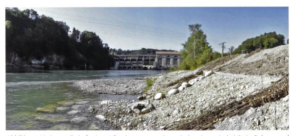
Abbildung 40: Das steile befestigte Ufer der Aare wurde nach dem Bau mit drei Stein-Buhnen und einer Kiesschüttung in eine Flachwasserzone umgestaltet. Während des Baus diente dieses Ufer als Ponton-Anlegestelle zur Verstärkung des Stauwehrs (hinten im Bild). (Foto: Heiko Zeh Weissmann)
