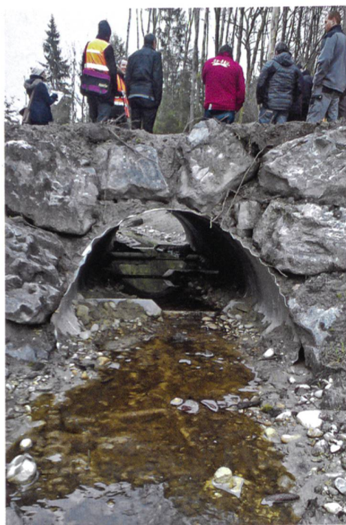
Abbildung 17: Wellstahldurchlass nach der Ausführung. (Foto: Niels Werdenberg)
