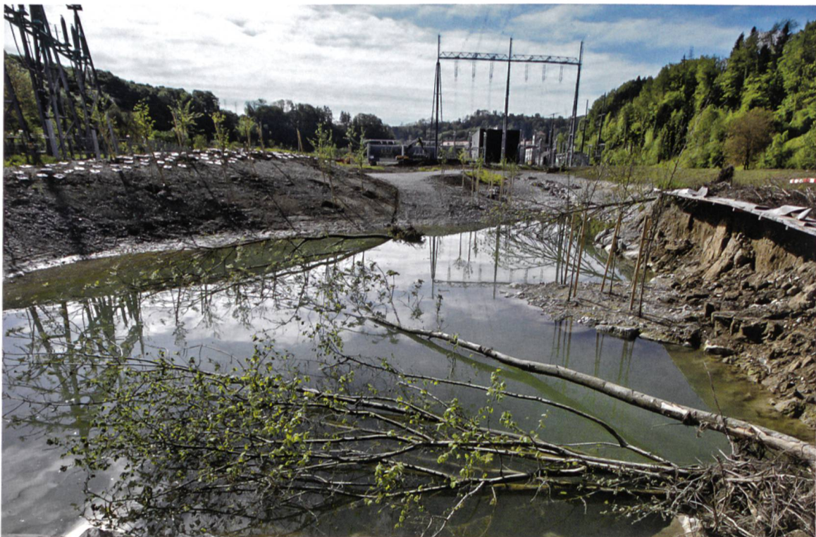
Abbildung 38: Ein Spezialfall bei der Unterstation Mühleberg ist die Nachbarschaft zur Aare und das entsprechende Aufwertungspotenzial. Deshalb wurde diese Restfläche zwischen den Abspanngerüsten als Altarm gestaltet. (Foto: Marco Zanoni)
