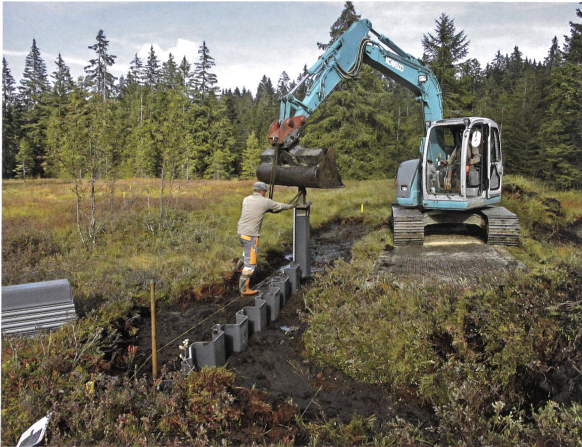
Abbildung 12: Einbau der Spundwände aus Hart-PVC. (Foto: Thomas Leu)
