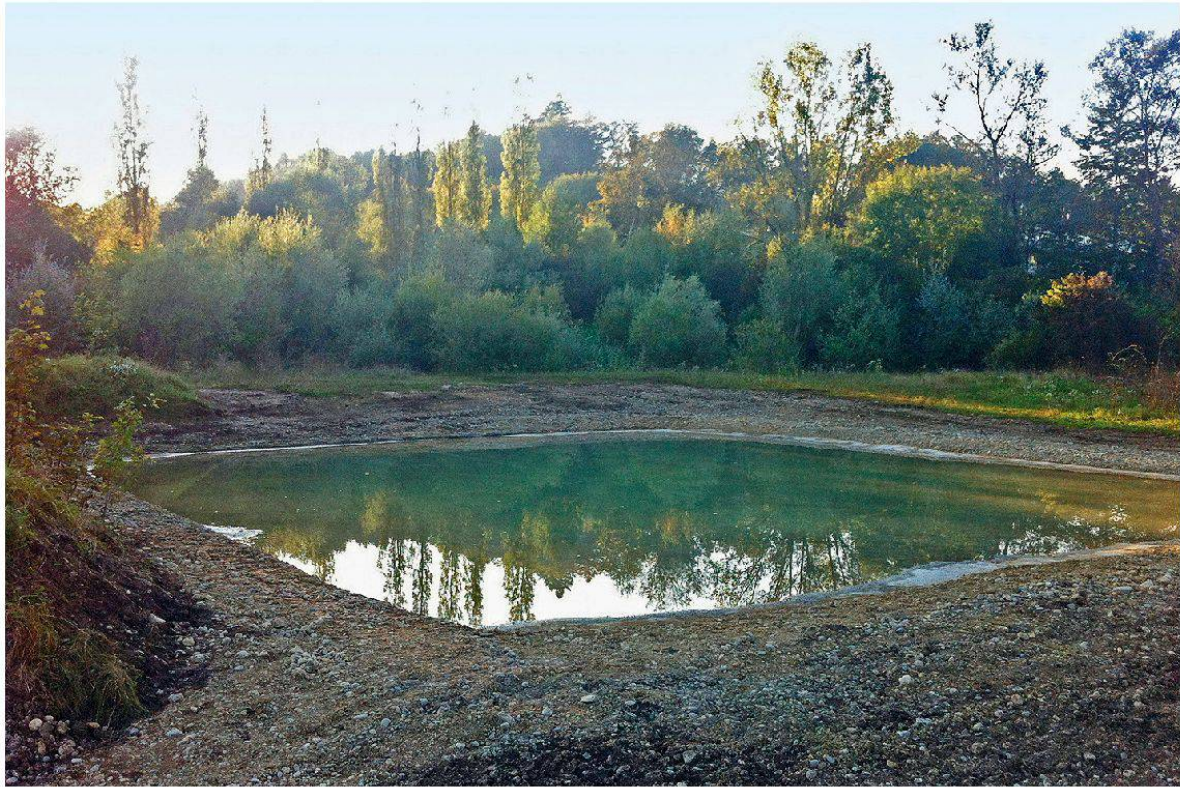
Figure 13: 12 cm de béton ont été déposés sur un revêtement étanche en caoutchouc et une natte de protection. (Photo: Olivier Bessire)
