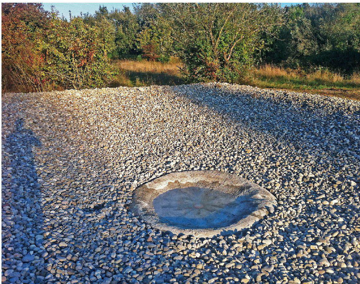
Figure 14: L'étang en gravier possède en son centre un système de vidange protégé par une collerette en béton maigre afin d'éviter l'obstruction de la conduite par le gravier. (Photo: Olivier Bessire)
