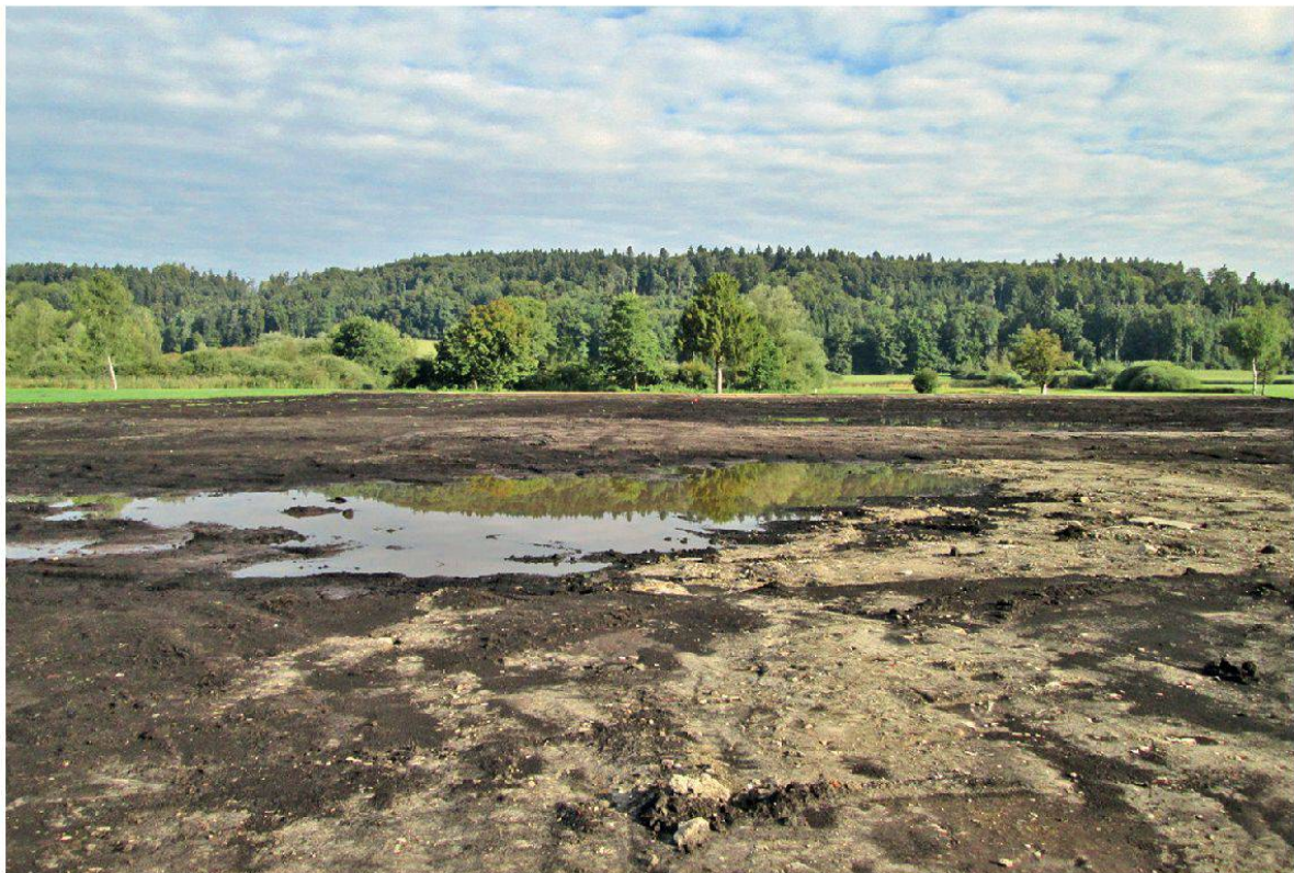
Abbildung 10: Auf der abgeschürften Fläche ist ein Grundwassertümpel entstanden. (Foto: Kissling+Zbinden AG)
