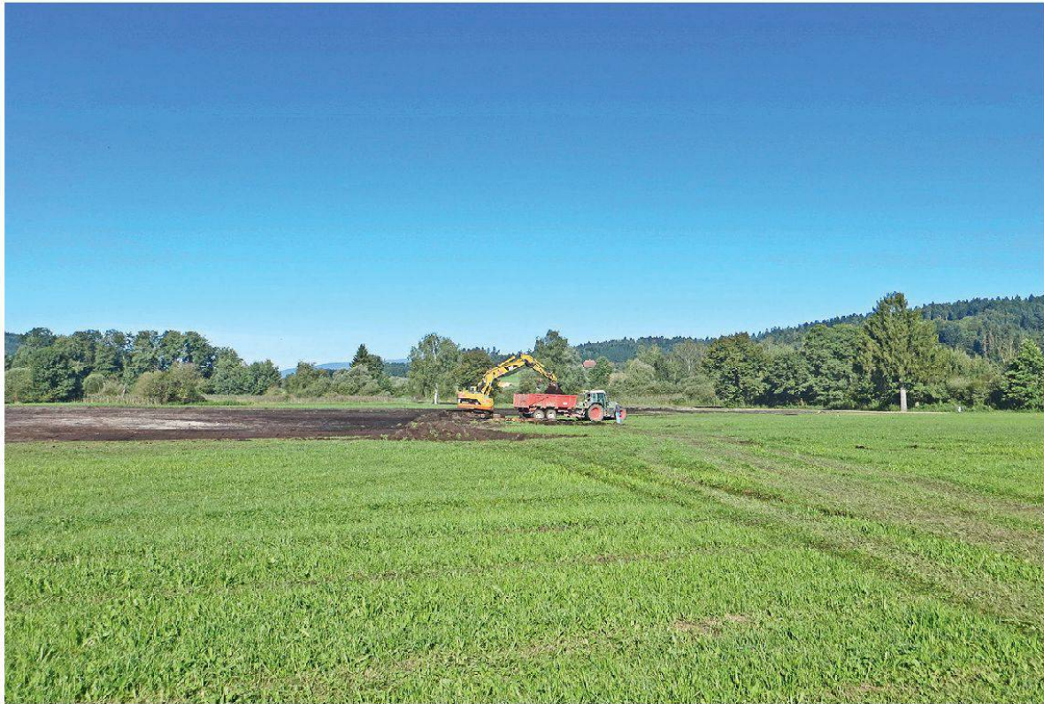
Abbildung 9: Abtrag von Oberboden und Abtransport des Materials. (Foto: Kissling+Zbinden AG)
