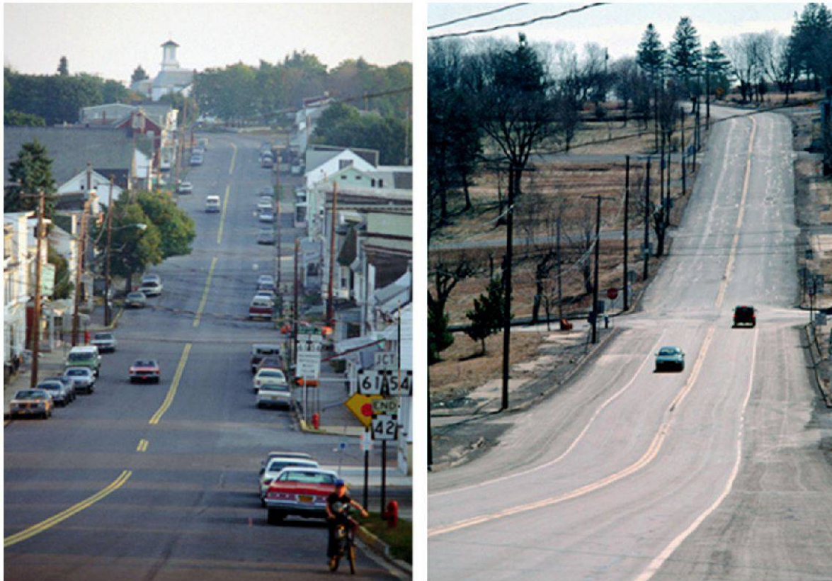
Abbildung 2: Locust Avenue Centralia. Zwischen den beiden Aufnahmen liegen 20 Jahre (links 1983, rechts 2001). Die beiden Aufnahmen zeigen eindrücklich, wie drastisch sich die Stadt aufgrund des Kohleflözbrandes innerhalb von bloss 20 Jahren verändert und entvölkert hat (Fotos David DeKok / Centralia Photo Archive).
