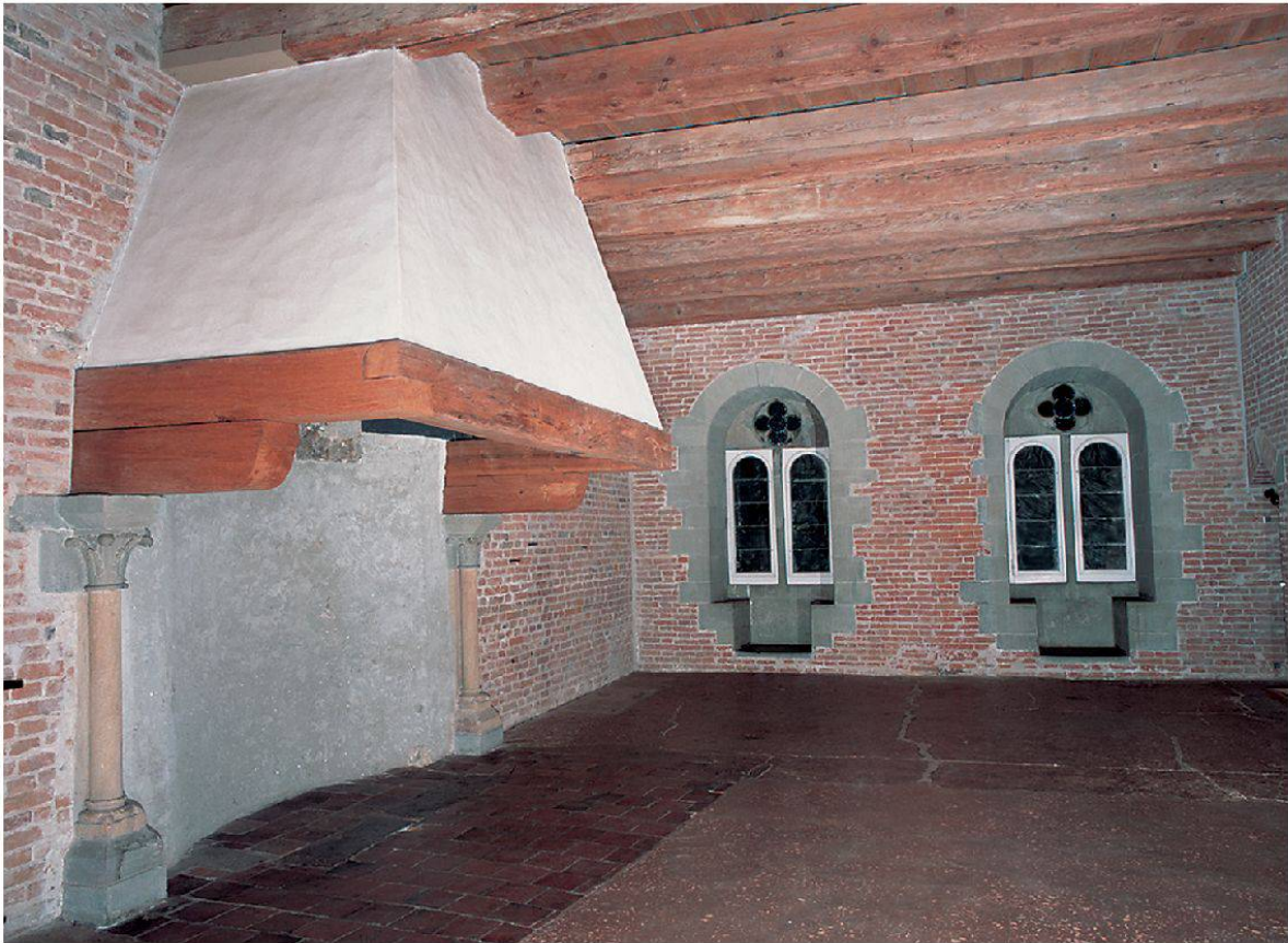
Abbildung 2: Das Cheminée heizte repräsentative Säle, hier den Rittersaal im Schloss Burgdorf, um 1200 (Abbildung Archäologischer Dienst des Kantons Bern).
