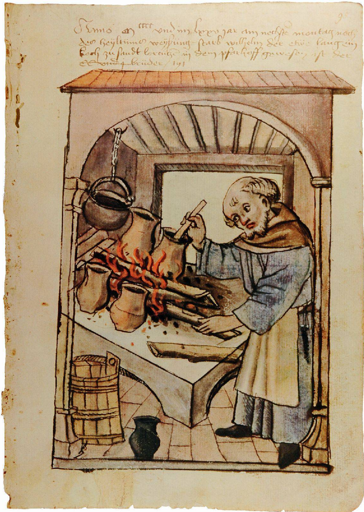
Abbildung 4: Blick in eine Küche im späten 15. Jahrhundert mit der Feuerstelle auf einem gemauerten Sockel (Mendelsche Zwölfbrüderstiftung um 1475, Abbildung Stadtbibliothek Nürnberg).
